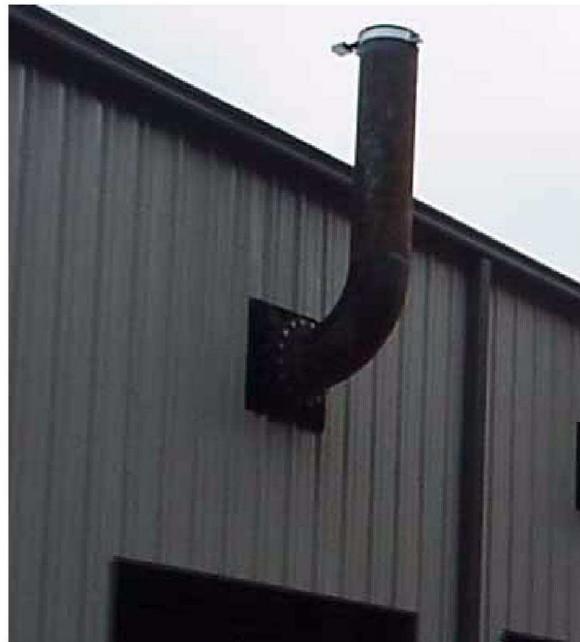
Rysunek 6-9. Prosty układ wydechowy wyposażony w daszek przeciwdeszczowy dla uniemożliwienia dostawania się deszczu do wydechu.
